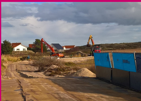
Graafwerkzaamheden verwijderen watercrassula
