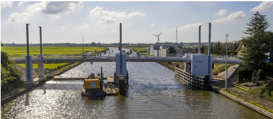
Huidige brug Dronrijp
