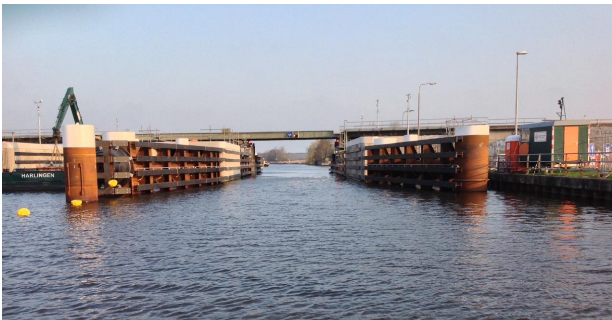
De nieuwe remmingwerken Swette-spoorbrug
